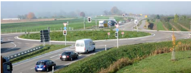
Turbo-Kreis mit Sicherung eines Fußgänger-Überwegs durch ein Lichtsignal (Achern: BAB-Anschlussstelle an der A5).
